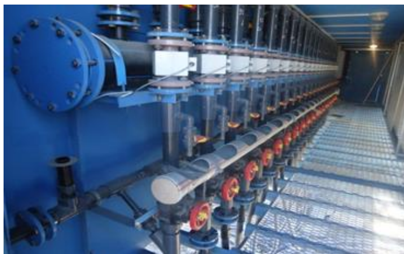
Сурет 3.8 – Айдау ұңғымаларын химиялық өңдеуге арналған қосымша құбыры бар ӨЕКТТ
